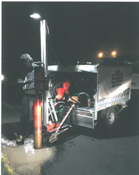
Figura 13. Carotatrice DD500 utilizzata per la taratura del georadar.
